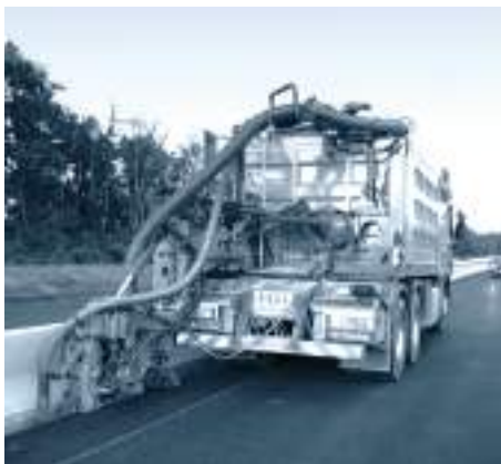
Создание автодорожных телекоммуникационных сетей.
